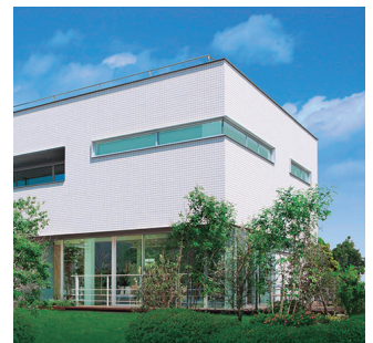
Casa inteligente. Ariake, Tokio. Climatizador combinado con generación fotovoltaica, pilas de combustible y baterías.
